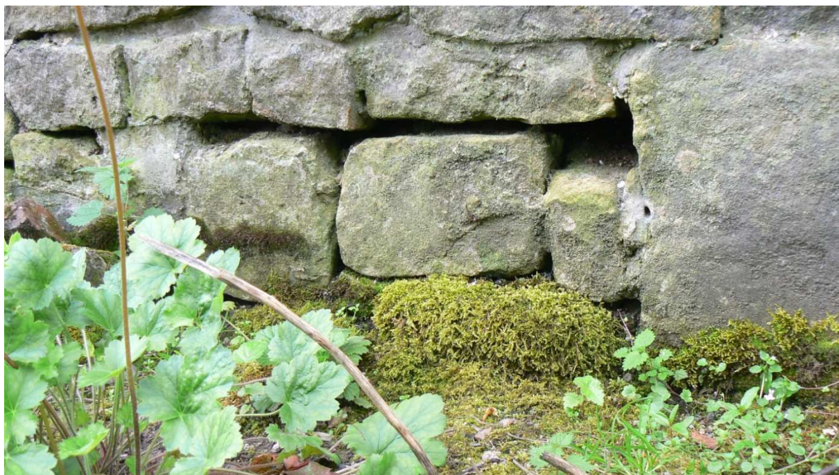
Fot. 9. Ubytki w spoinach podmurówki od strony ogrodu – bud. 14.
