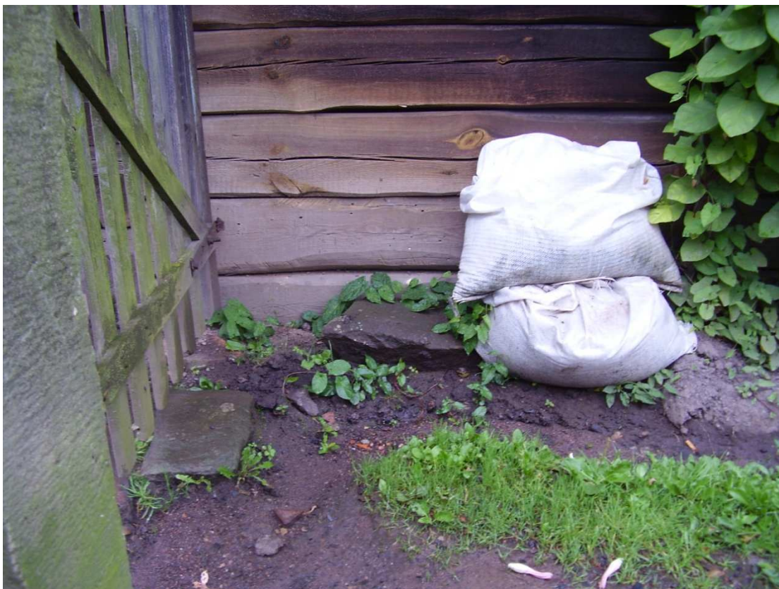
Fot. 14. Brak murowanego cokołu i odwodnienia liniowego (zalewanie ściany zewn.) – bud. 23
