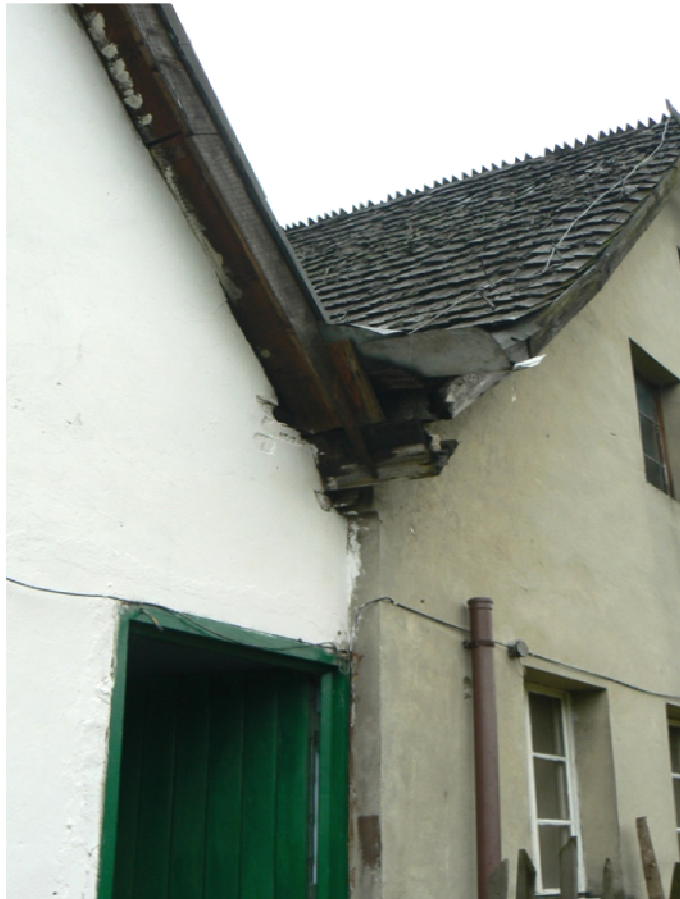
Fot. 12. Uszkodzenie kosza i rury spustowej – bud. 20-21.
