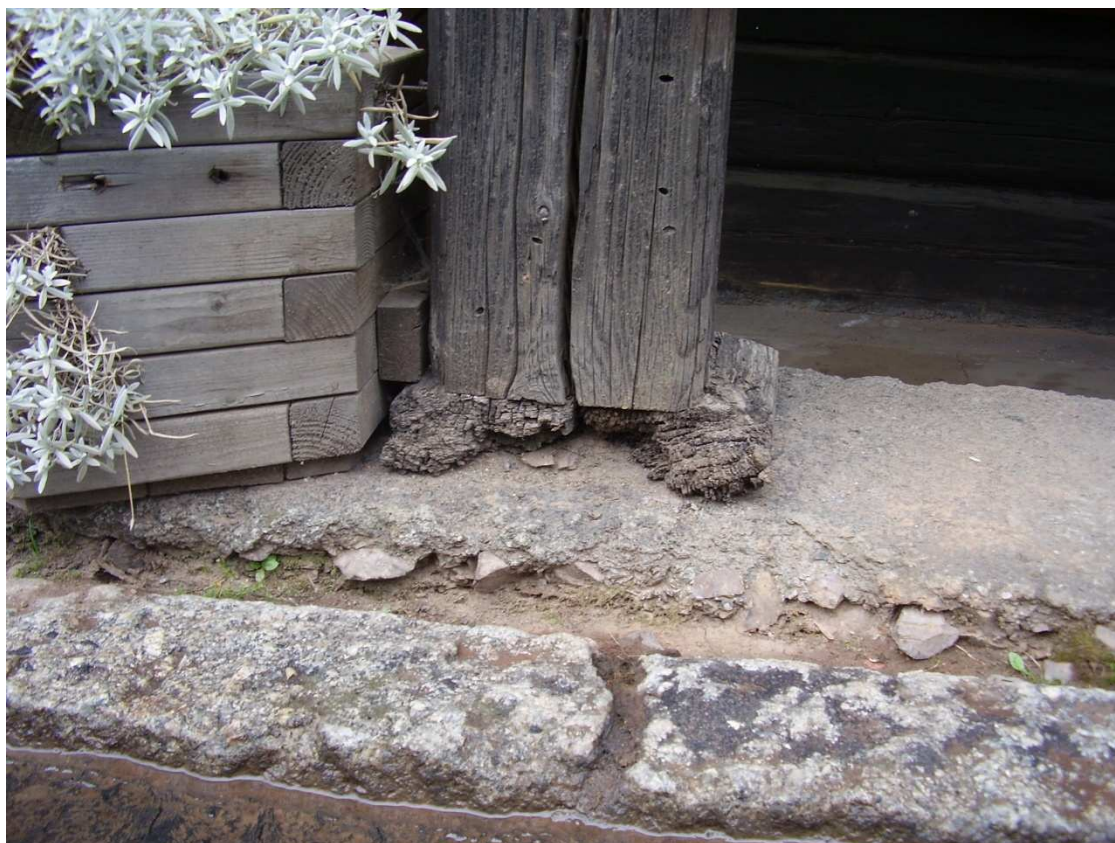
Fot. 4. Zdegradowane drewniane podstawy większości słupów.
