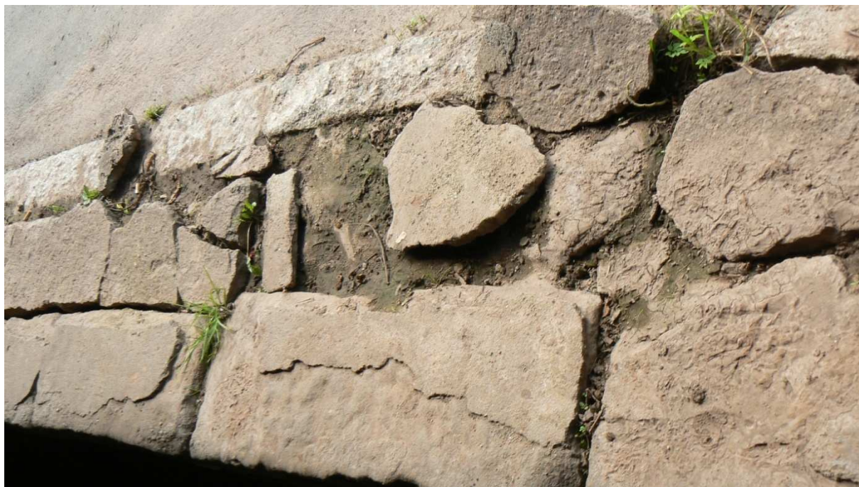
Fot. 1. Zdegradowany murek oporowy pomiędzy jezdnią a podcieniem
