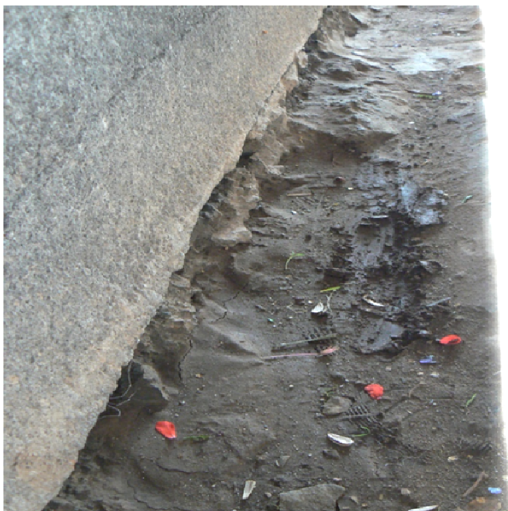
Fot. 3. Brak odwodnienia podcienia
