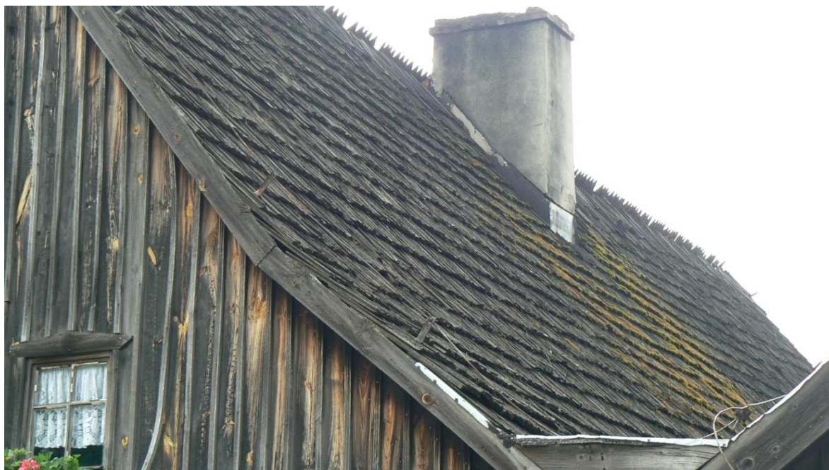
Fot. 7. Wypaczone listwy maskujące, brak obróbek, zdegradowane poszycie dachowe, ubytki w koronie komina.
