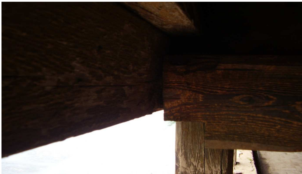
Fot. 2. Brak słupa podpierającego podcień oraz obniżenie belki przy bud. 20
