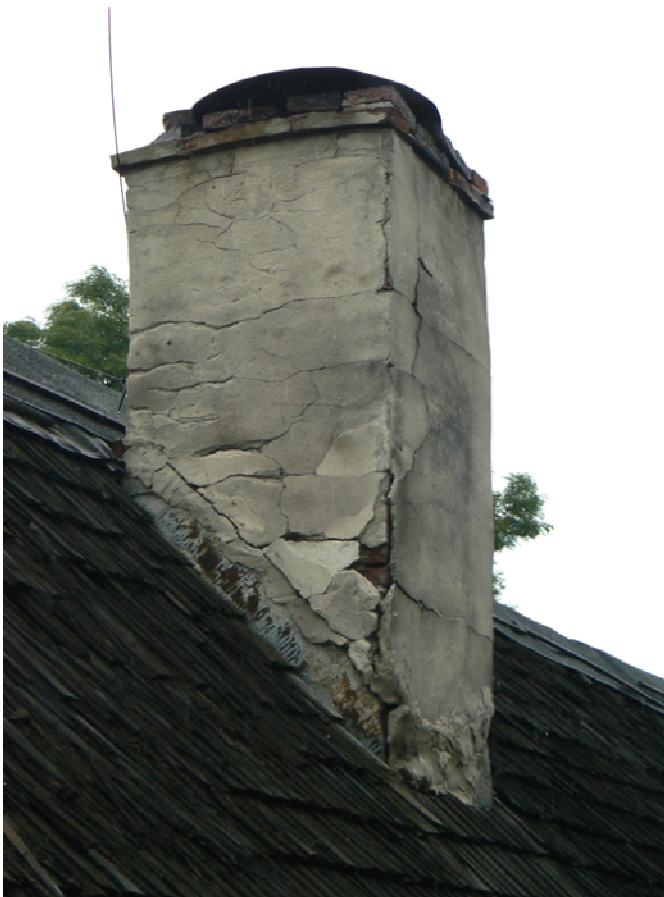
Fot. 6. Zniszczona połać dachowa, uszkodzony komin, brak obróbek blacharskich – bud. 17.
