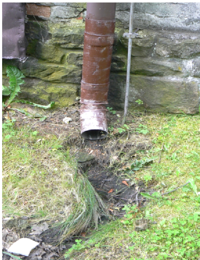
Fot. 13. Brak odprowadzenia wód opadowych od budynku – bud. 14.
