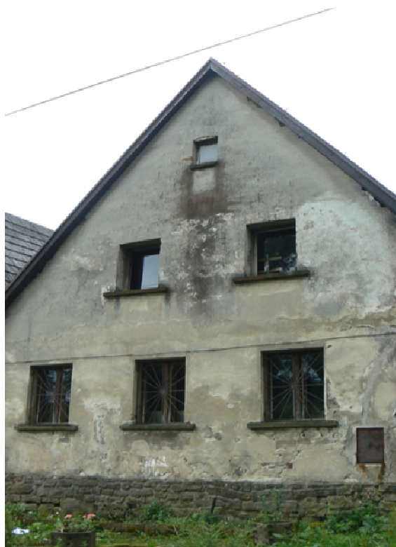
Fot. 11. Ubytki w tynku ściany szczytowej na styku w połacią dachową, zniszczona kolorystyka elewacji.
