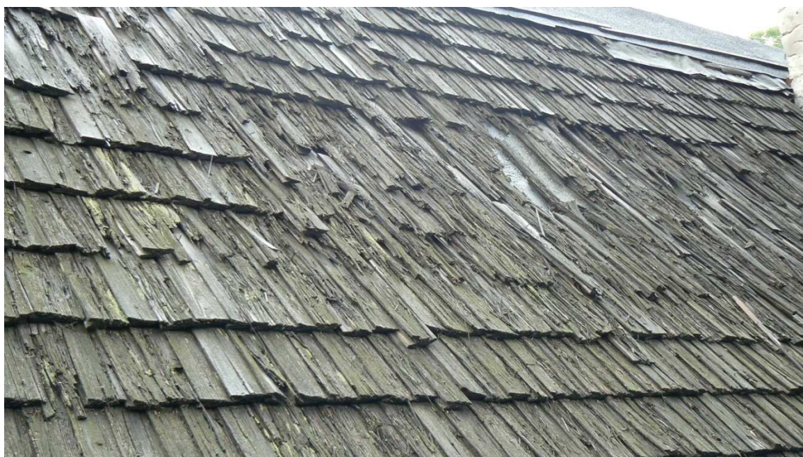
Fot. 5. Zniszczona połać dachowa – bud. 17.
